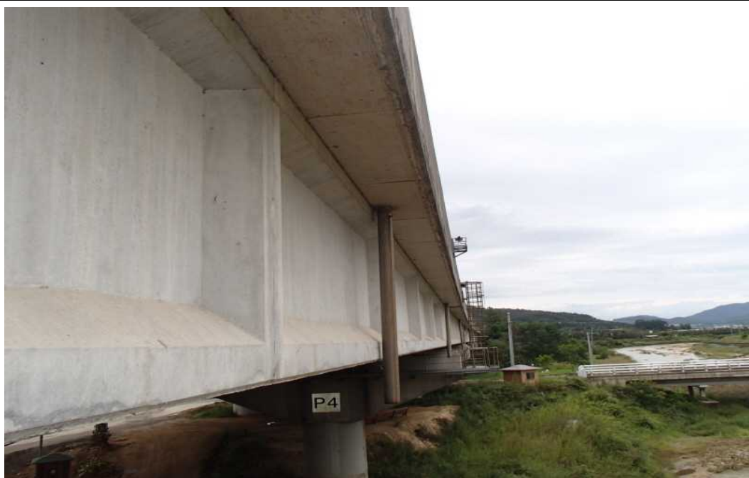
PSC 거더 측면 전경
